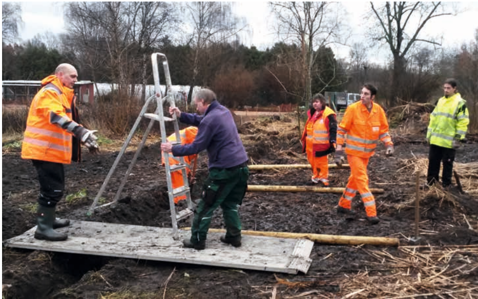
UMFANGREICH: Der Umbau im Gartenbau war an vielen Stellen deutlich zu beobachten.
