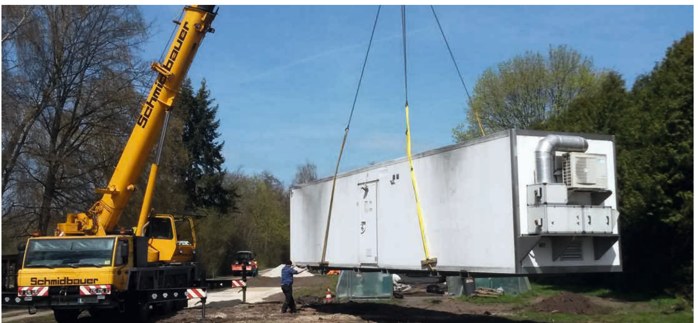
KÜHLCONTAINER: In diesem werden die Eier des Rent-a-Huhn-Projektes gelagert.
