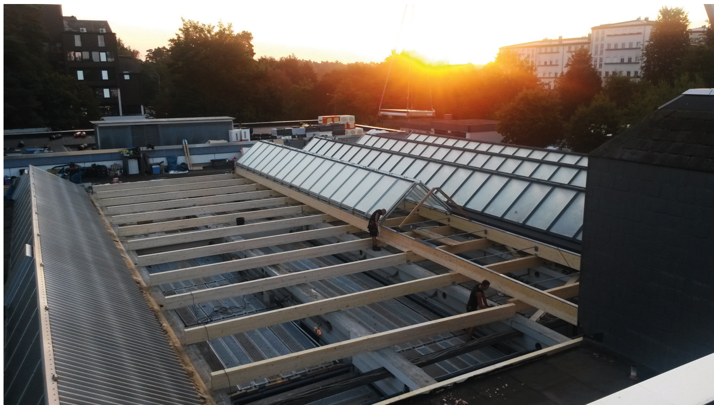
VIEL LOS: So sah die Baustelle von oben betrachtet aus.
