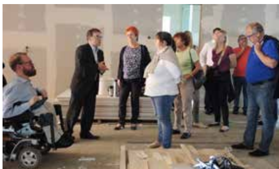
WEIT FORTGESCHRITTEN: Die Baustelle der kükkenkoje geht langsam in die finale Phase.
