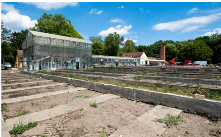
ALLES NEU: Hier entstehen die neuen Gewächshäuser für den Pflanzenanbau.
