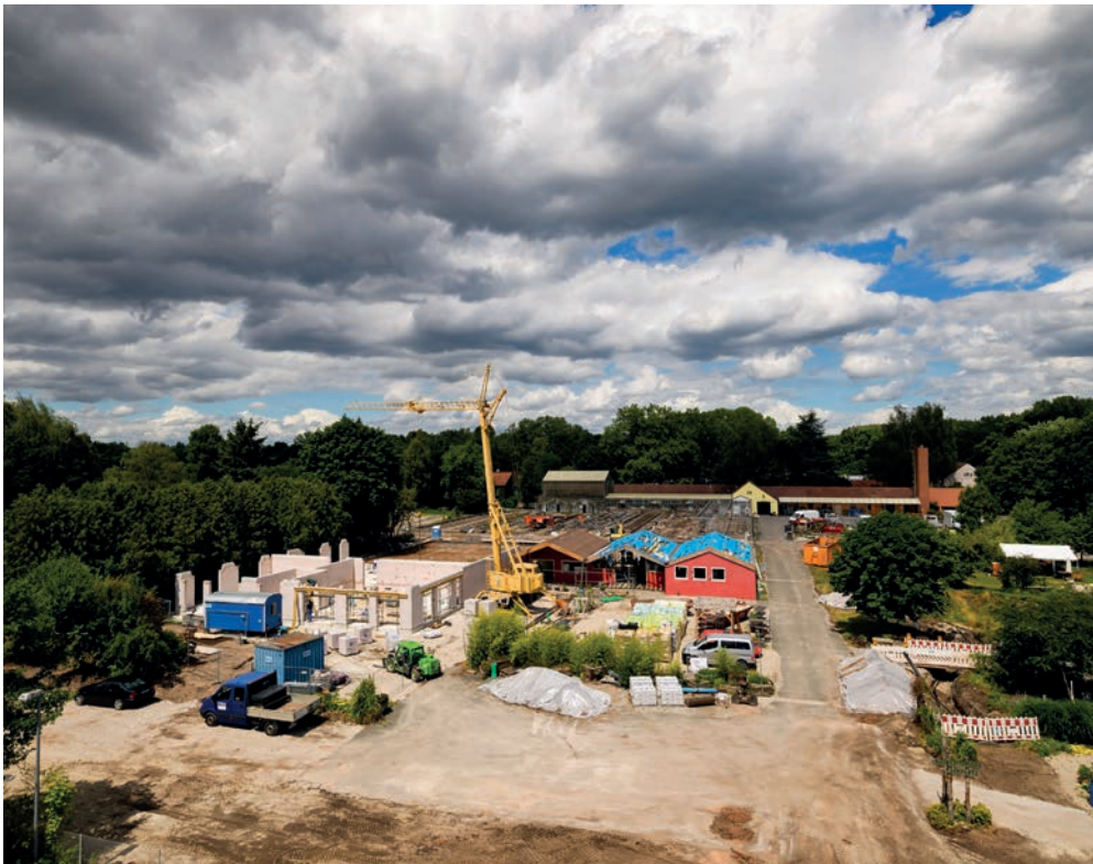
AUS LUFTIGER HÖHE: Ein Blick auf die Gebäude der neuen Töpferei.
