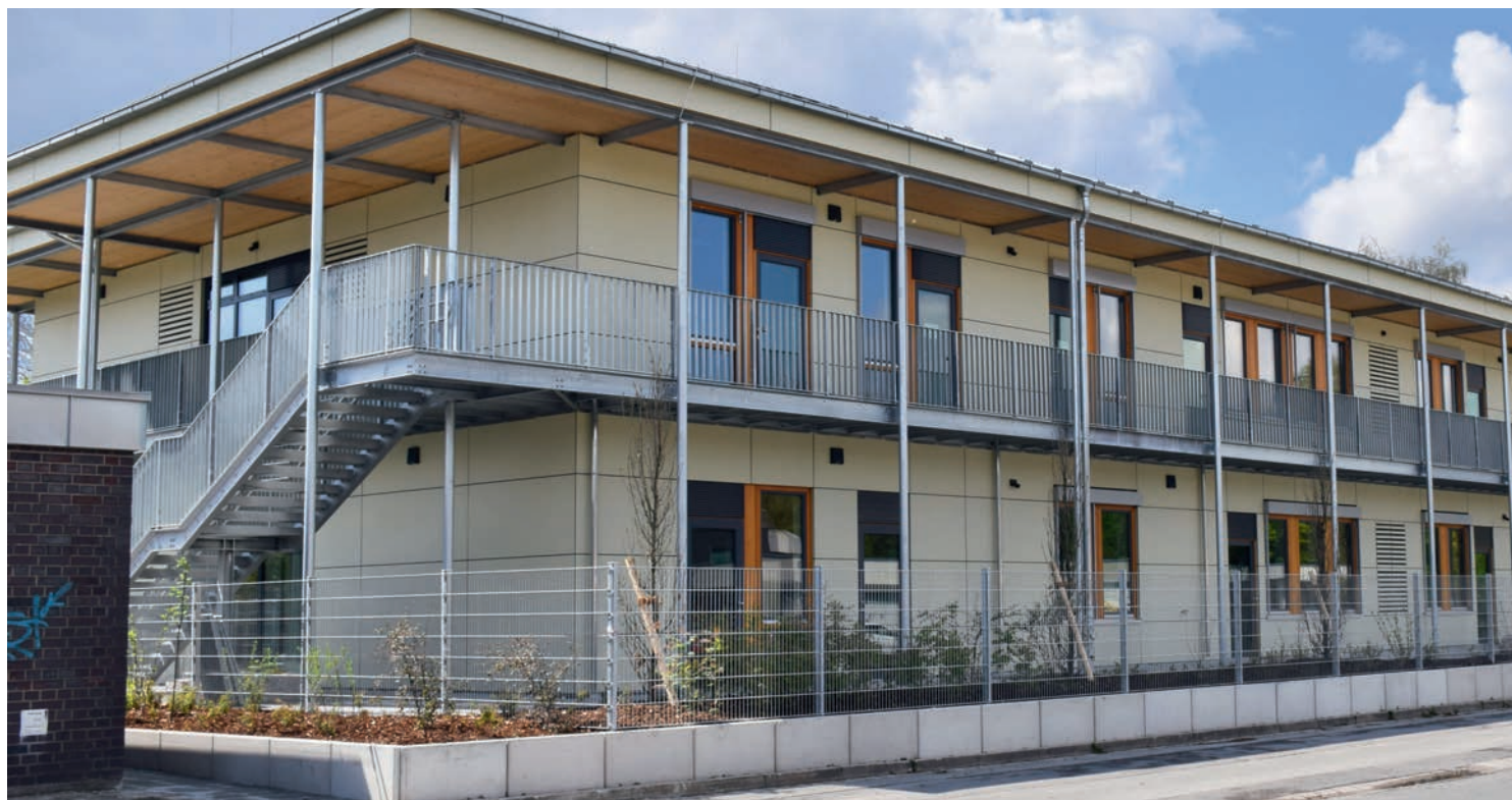
HÄUSLE BAUE: Mittlerweile ist das Gerüst rund um die neue Kindertagesstätte verschwunden.
